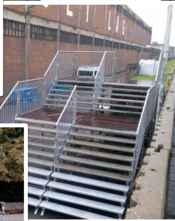
Acceso mediante escaleras
